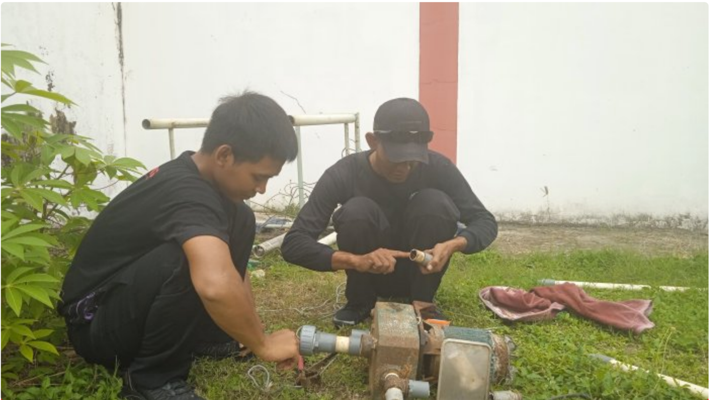
Minimalisir Kerusakan, Staff Umum Lapas Pasir Putih Lakukan Servis Berkala Pompa Air
