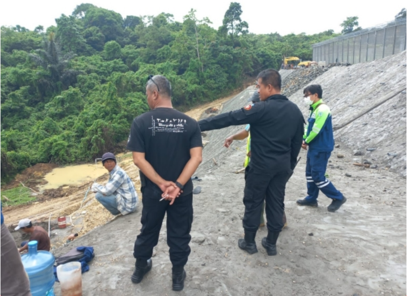
Garap Turap GRBB PT. SBI, Plt. Kalapas Karanganyar: Turap ini Sebagai Penahan Bencana Alam Tanah Longsor
